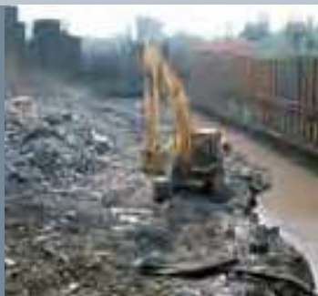
Строительство и туннели
